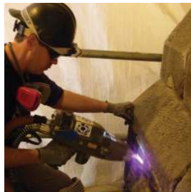
تمیز کاری سنگ با استفاده از لیزر
